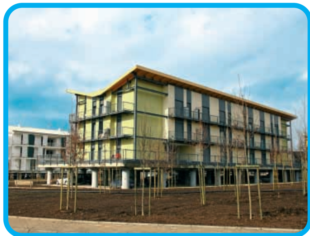
Palazzine residenziali, Piano C.A.S.E, Paganica (L'Aquila): tamponamento esterno Aquapanel®
