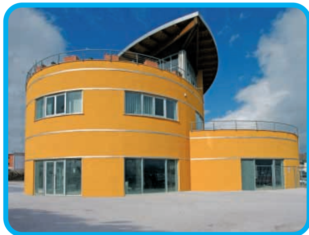
Ordine degli Ingegneri, L'Aquila: tamponamento esterno Aquapanel®
